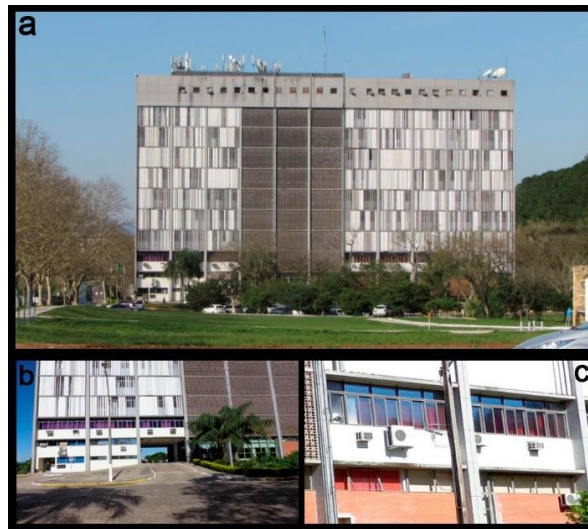
Figura 3. Imagens das fachadas do prédio da Reitoria: (a) fachada oeste; (b) detalhe da passagem de veículos no térreo; (c) aparelhos de ar condicionado fixados aleatoriamente nas fachadas.
